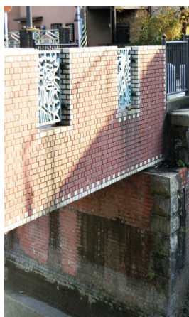
若江鉄道の鉄橋を活用した大津絵橋の煉瓦づくりの橋げた
