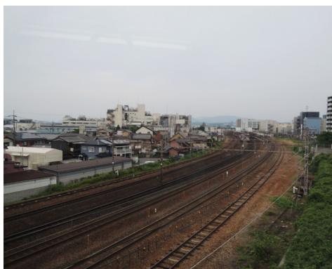
粟津駅 - 京阪石山駅では JR の線路が見下ろすことができる
